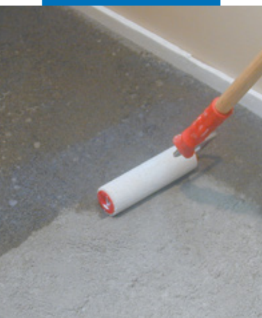
Aplikace Primeru G válečkem
